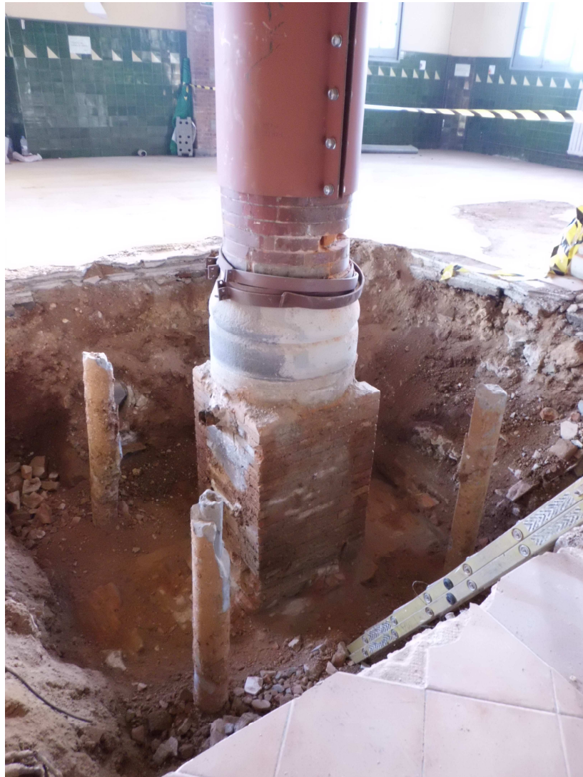
Vista de les estructures documentades en el Sondeig 1
